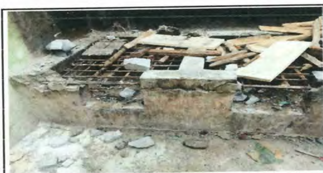
Foto 11: Mejoramiento de polletones de cocina
