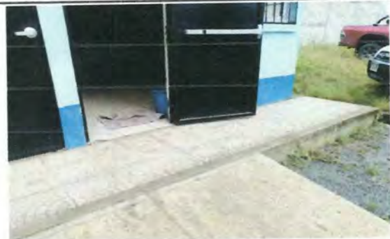
Foto 7: Cambio de piso de corredores por piso ceramico
