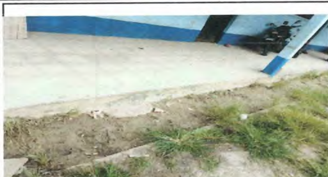
Foto 1: Cambio de piso de corredores por piso ceramico
