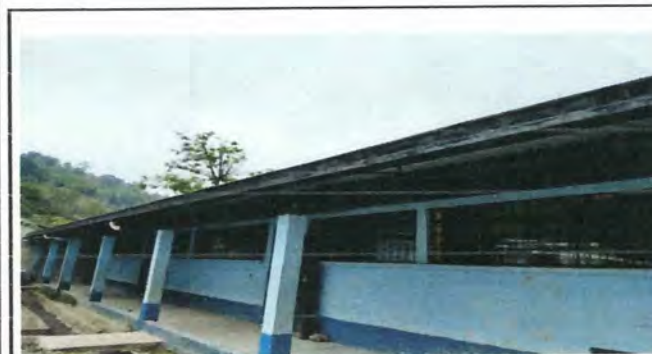
Foto 3: Cambio de piso de corredores por piso ceramico
