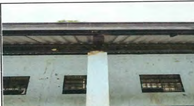
Foto 10: Arreglo de bajadas de agua pluvial
