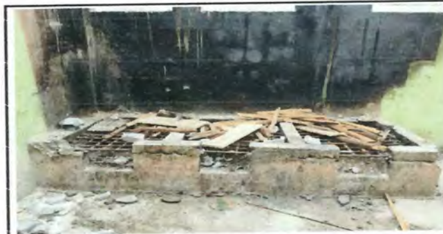
Foto 12: Mejoramiento de polletones de cocina
