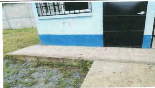
Foto 8: Cambio de piso de corredores por piso ceramico
