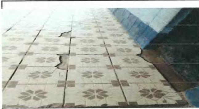
Foto 2: Cambio de piso de corredores por piso ceramico
